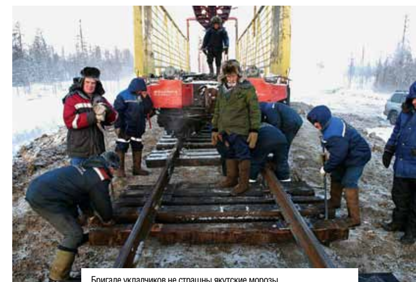
Бригаде укладчиков не страшны якутские морозы
