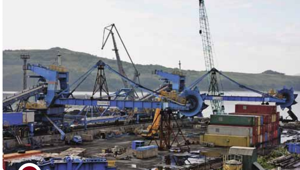
Монтаж стакеров-реклаймеров обновляемого порта Посыет
