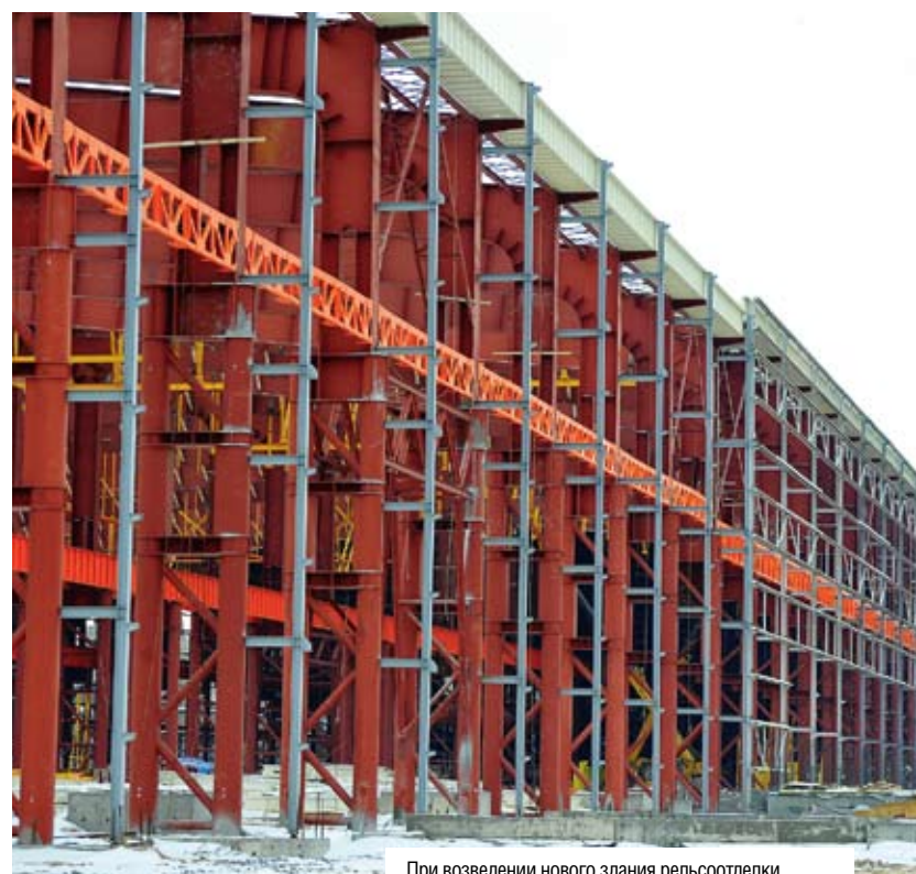
При возведении нового здания рельсоотделки применяется современный металлобетонный каркас
