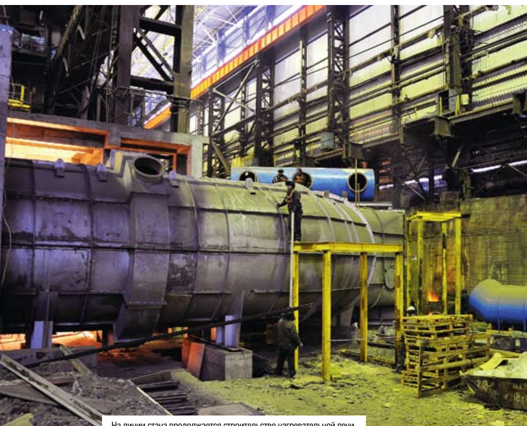
На линии стана продолжается строительство нагревательной печи
