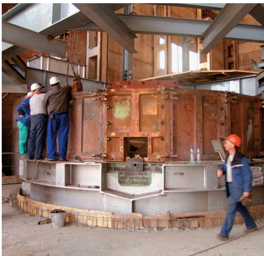
На «Южуралникеле» идет монтаж опытной плазменной печи
