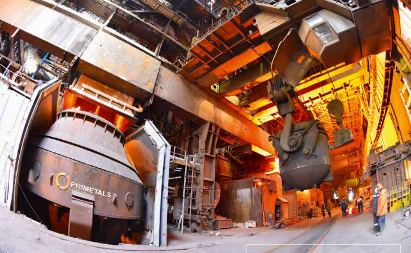
КОНВЕРТЕР №1 В КИСЛОРОДНО-КОНВЕРТЕРНОМ ЦЕХЕ В 2020 ГОДУ ФАКТИЧЕСКИ ВЫСТРОЕН ЗАНОВО И ОСНАЩЕН ТРЕХСТУПЕНЧАТОЙ СИСТЕМОЙ ГАЗООЧИСТКИ
