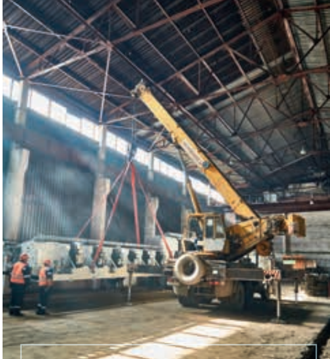
СЕНТЯБРЬ 2020 ГОДА. РАЗГРУЗКА ПЕРВЫХ ВОЛОЧИЛЬНЫХ МАШИН, КОТОРЫЕ ПРИШЛИ НА КОМБИНАТ В РАМКАХ ПРОЕКТА ПО МОДЕРНИЗАЦИИ СТАЛЕПРОВОЛОЧНО-КАНАТНОГО ПРОИЗВОДСТВА
